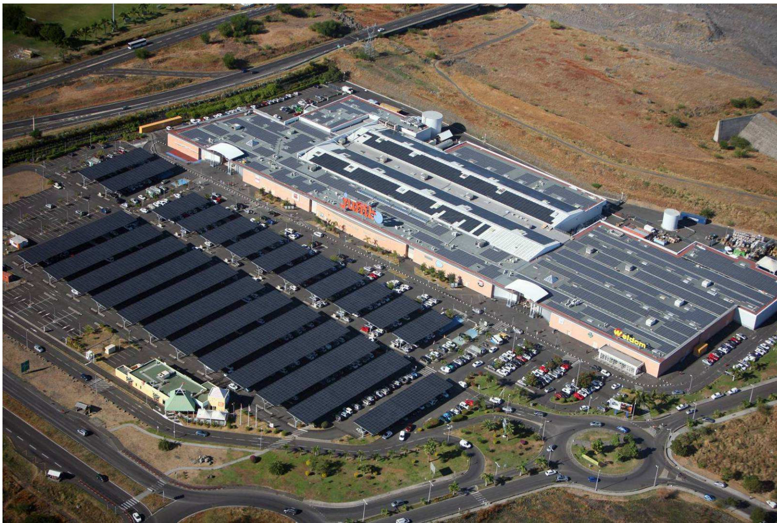
Le Port (La Réunion) – 3 900KWc – Mise en service septembre 2010
